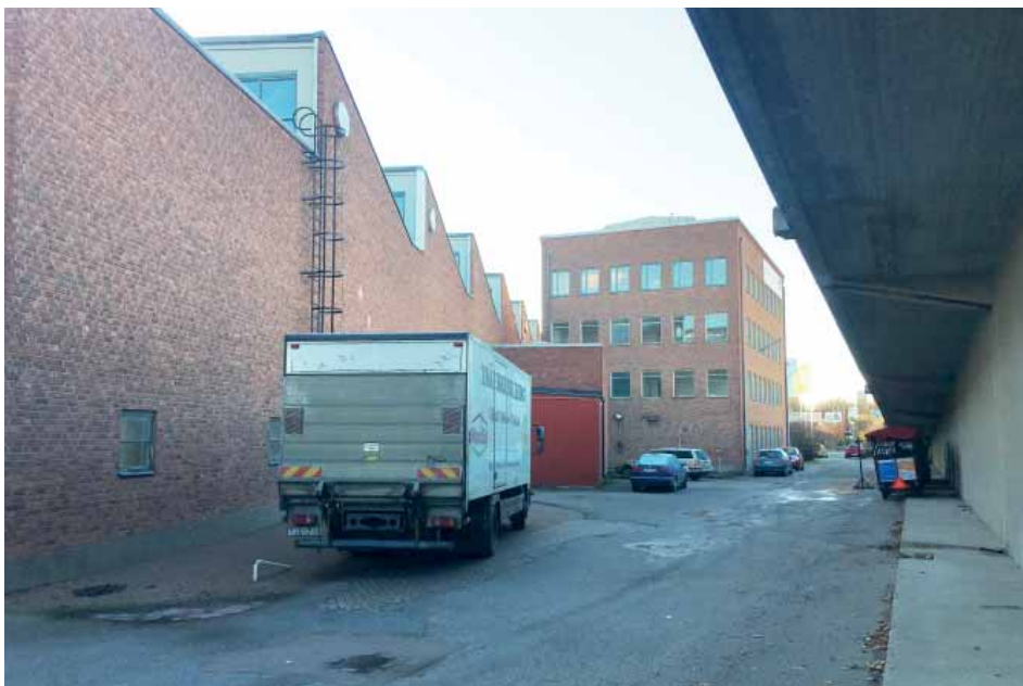
Otrygg plats vid Linverket Konsolen under Kopparbergsvägen utmed Linverket är en potentiellt otrygg plats. Möjligheten att gömma sig bör byggas bort och miljön ges en mer omhändertagen gestaltning och belysning.
